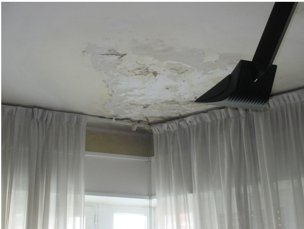
Foto 16: infiltrazione - particolare
